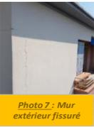
Photo 7 : Mur extérieur fissuré
