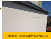
Photo 6 : Mur extérieur fissuré
