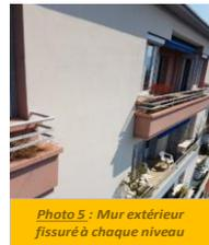
Photo 5 : Mur extérieur fissuré à chaque niveau
